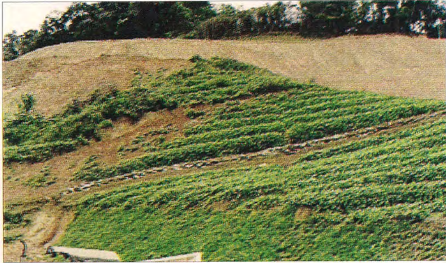
Alur Memanjang Lebih Baik Dari Alur Menegak Dalam Kerja-Kerja Hydroseeding
