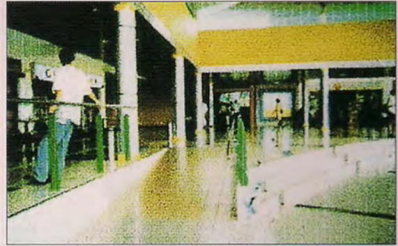
Foto 6 : 'Ramp' untuk pengguna kerusi roda di Restoran Jejantas Sg. Buloh, Lebuhraya PLUS.
