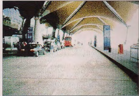
Foto 2 : Tempat menurunkan penumpang di KLIA yang boleh digunakan oleh golongan orang kurang upaya dengan selesa.
