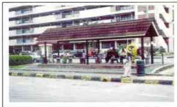
Kemudahan Perkhidmatan Bas Yang Selesa Merupakan Salah Satu Dari Elemen Pengangkutan Untuk Tujuan Kemudahsampaian Penduduk Ke Kawasan Perumahan dan Aktiviti Utama.
