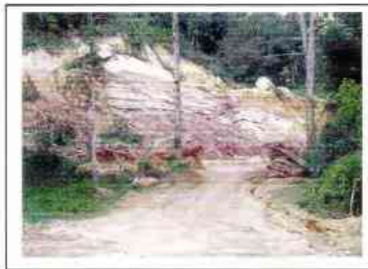
Tapak Pembangunan Kesan Dari Pemotongan Tanah Di Kawasan Bukit Yang Tidak Terkawal Dan Perlu Dielakkan.
