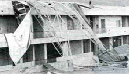
Papan iklan bumbung yang telah rebah akibat angin kencang semasa ribut hujan batu di Petaling Jaya, 2000.
