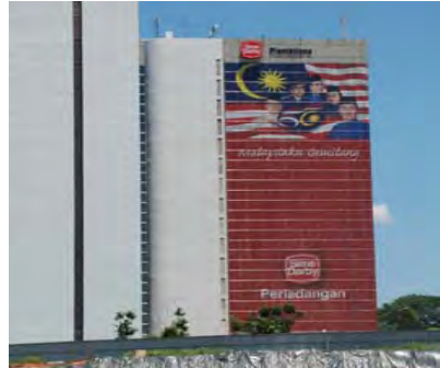
Iklan building wrap perlu menggunakan bahan yang membenarkan kemasukan cahaya dan udara semula jadi serta tidak menghadkan bukaan pada bangunan.
