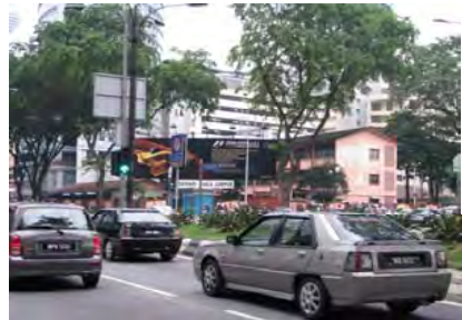
Pemasangan papan iklan yang melindungi bangunan sekolah dari pandangan awam di Jalan Raja Laut, Kuala Lumpur.
