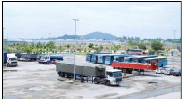
Foto 7: Pembangunan Terminal Kenderaan Berat Durian Tunggal yang kedudukannya jauh daripada kawasan petempatan sedia ada.
