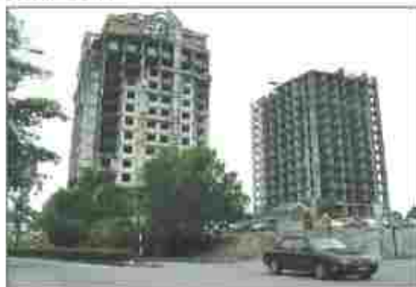
Foto 39: Projek pembinaan hotel terbengkalai di Jalan Toman 2, Seremban, (Mac 2007).
