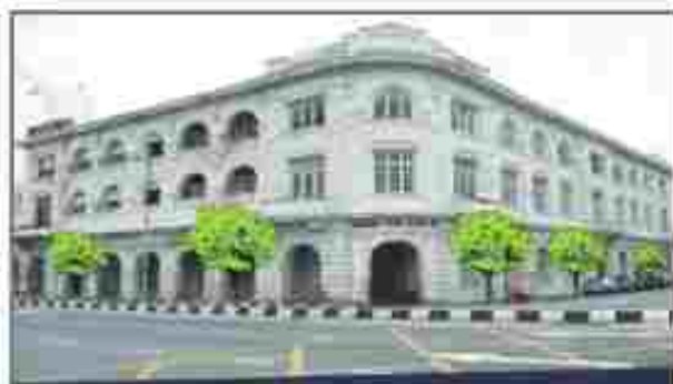
Foto 38: Pengkelan fasad bangunan Wisma Yeap Choor EE, Pulau Pinang (Januari 2010).
